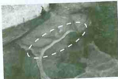
石のすき間や割れ目は微生物の温床になりやすいため、日常業務の中で発見したら直ちに処置する。写真はすき間にモルタルで塞いだ箇所（破線部分）
